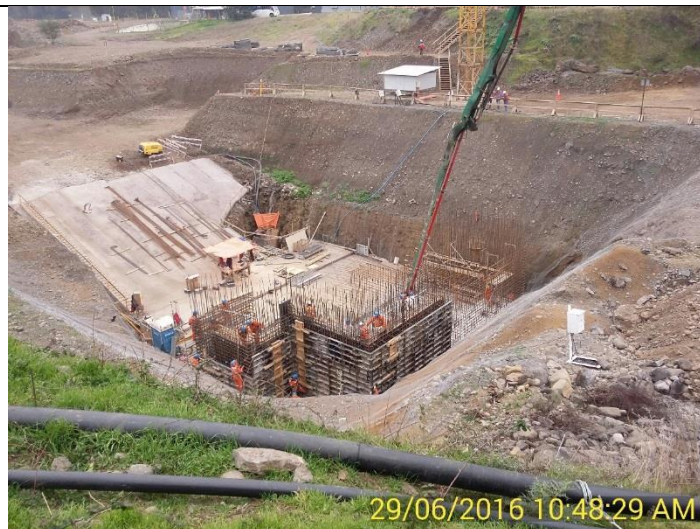
Hormigonado, con H25, de los muros: 1/2 N° 1, 4, 5 y 6 de la 1ª Etapa de Hormigonado. Lado Sur Casa de Máquinas.
