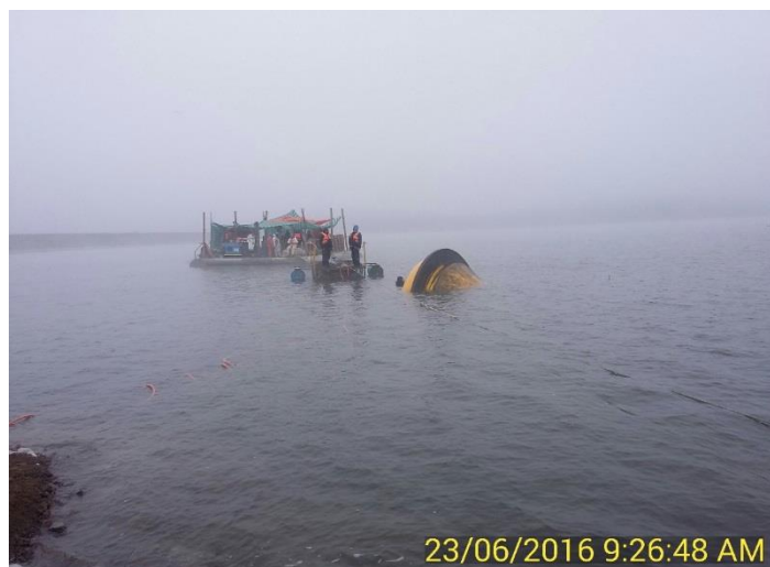
Al tratar de hundirlo llenándolo con agua, el Tapón Toriesférico se gira en 90°, quedando flotando de costado, como se aprecia en la fotografía superior.
