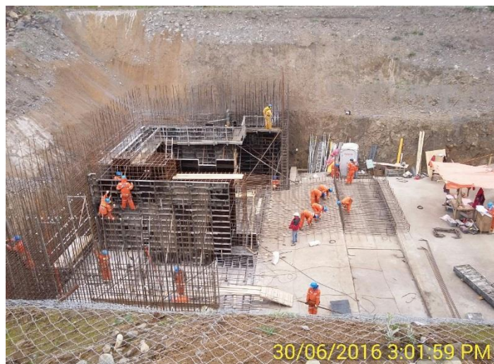
Moldaje muro N° 3, Malla de Tierra e inicio de la colocación de la enfierradura de la 3ª Etapa de Hormigonado de la Casa de Máquinas.
